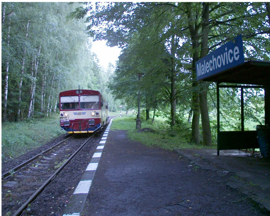
Stavebně náročný byl úsek kolem Malechovic. V době otevření tratě zde vlaky nestavěly, zastávka byla otevřena až 12. července 1908. Foto autor, 2007
